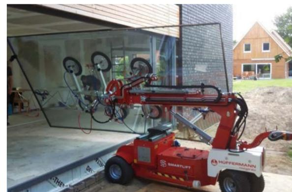
– an dem der Glassauger befestigt ist, begrenzt die Arbeitshöhe. Mit diesem 3D Vakuum – Glasmanipulator wird das Angebot der Glasmontagegeräte vollendet.
